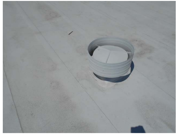
Photo #34: Roof Exhaust Fan
