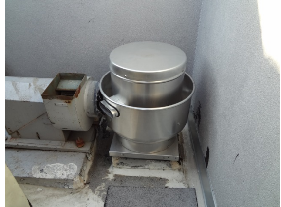
Photo #50: Rooftop Exhaust Fan
