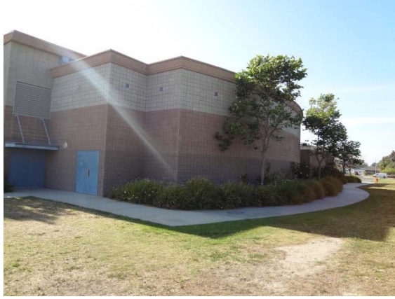
Photo #31: CMU Façade (Gym)
