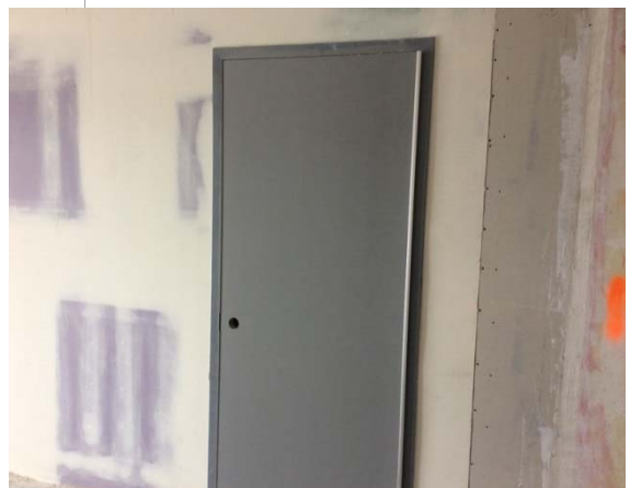
Photo #42: Metal interior door
